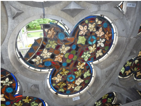
Der Sturmschaden aus der Nähe
